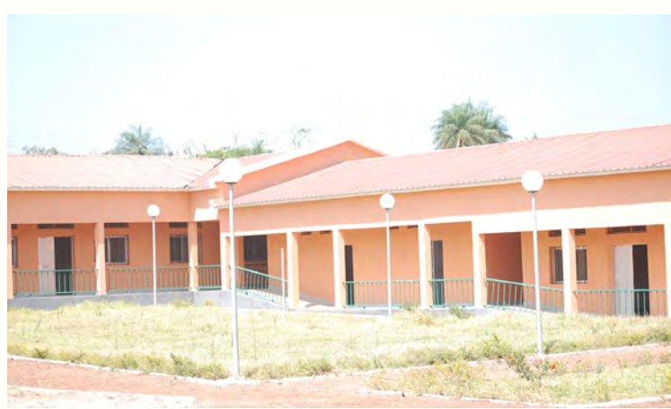
Novo edifício da Escola Nacional de Surdos Mudos da Guiné-Bissau
